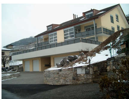
Implanté à flanc de coteau
