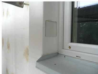
Système de nouvelle fenêtre
