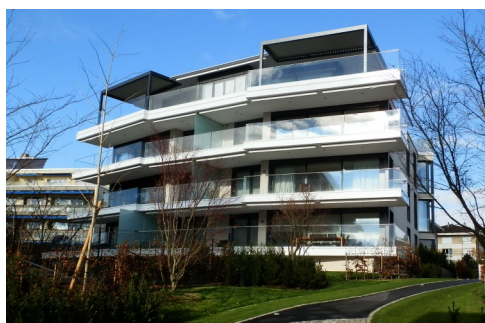
Façade sud Eden Parc
